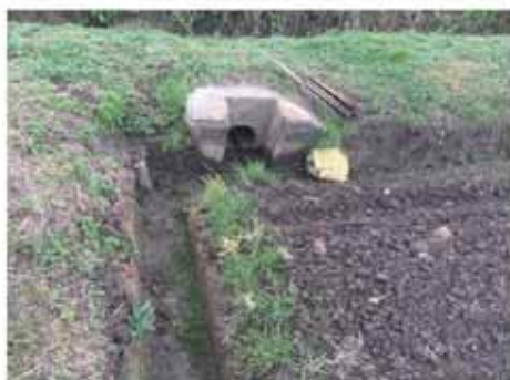
【周囲溝と排水溝をつなげた圃場】
